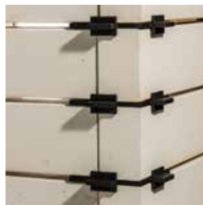
Gussplättchen dienen als Abstandhalter zwischen den Feuersteinen
